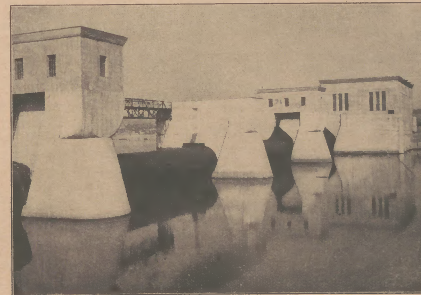
Den Abfluß des Hengstensees bilden ein Wehr mit 4 beweglichen Walzen und ein Laufkraftwerk, das das anfallende Wasser kraftwirtschaftlich ausnützt
