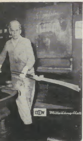
Gesenkgeschmiedete Turbinenschaufeln für Dampf- und Gasturbinen sind eine Spezialität des Werkes Remscheid. Härter Hermann Schmebeck geht sorgfältig mit ihnen um; denn sie dürfen sich beim Härten nicht verziehen.
