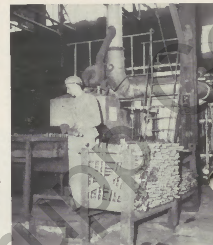
Härter Georg Bieler fährt die Salzbad-Isotherm-Glühanlage.
