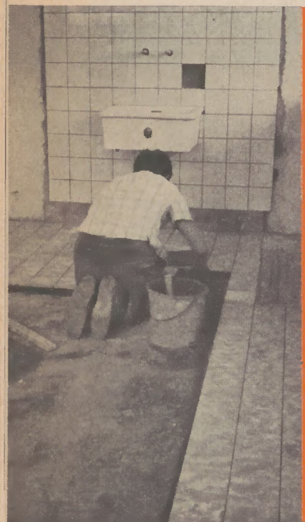
Jetzt arbeitet der Fliesenleger
