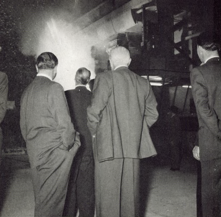
▲ Auf der Konverterbühne des Thomaswerkes: Professor Heuss (zweiter von rechts) bei der Beobachtung eines Blasvorganges
