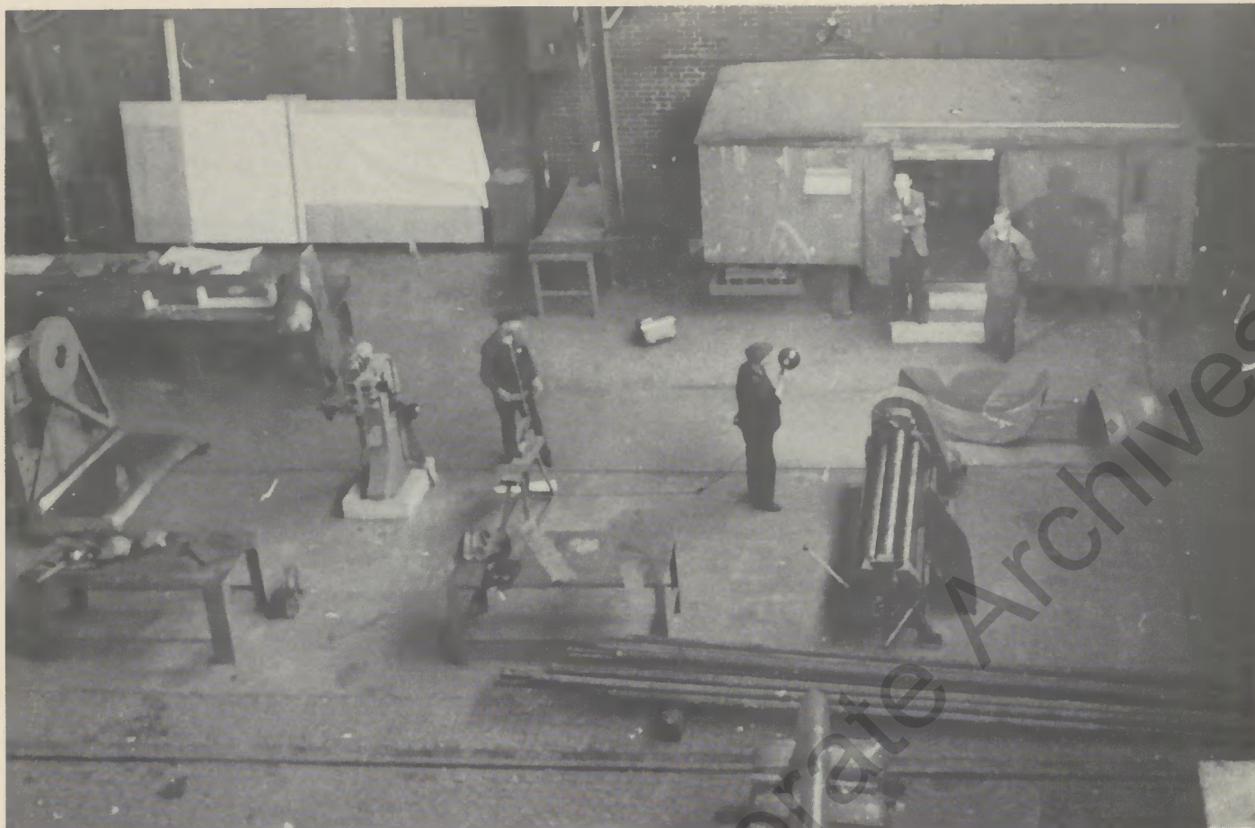
Blick in die Halle M 45 mit dem „Büro“
