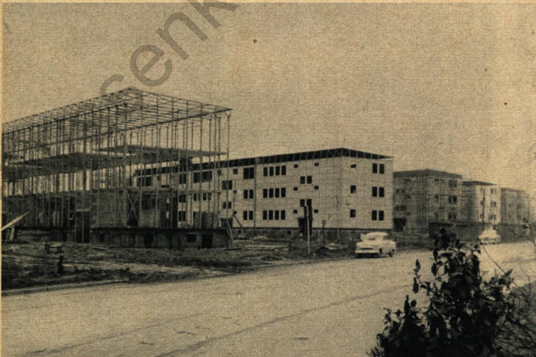
▼ 252 Familien werden in dieser Siedlung, die von unserer „Gemeinnützigen Wohnungsbaugesellschaft Helm und Scholle“ an der Bischoffstraße in Hoesch-Fertigbauweise errichtet wird, gute und freundliche Wohnungen finden. Neben den Wohnhäusern wird auch das gemeinsame Waschhaus mit Fernwärme versorgt
