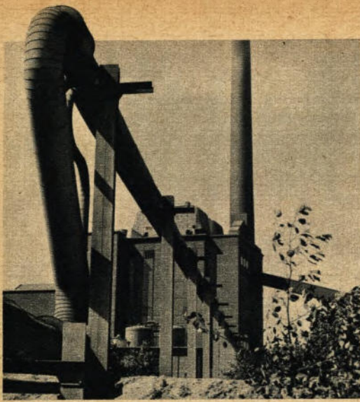
▲ Wie eine sich aufbäumende Schlange, so erscheint das mächtige Dampfrohr, das aus dem Hoesch-Kraftwerk Emscher kommt und den Dampf mit dreißig Atmosphärenüberdruck und vierhundert Grad Celsius zur Schachtanlage Fritz-Heinrich führt
