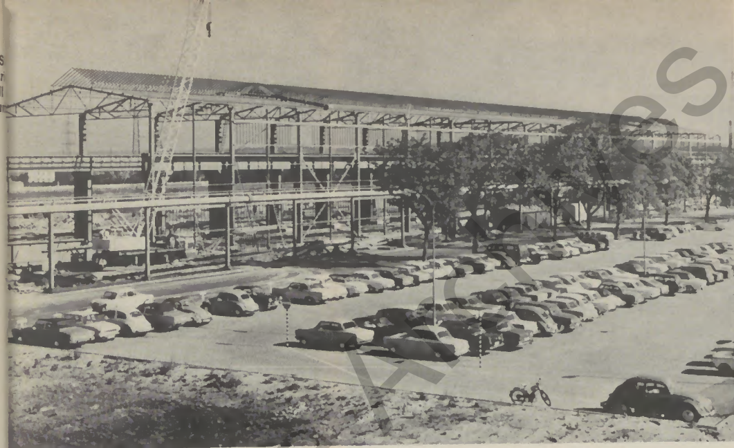
Das Bürogebäude an der Seite der Rohrwerk-Kaltbeton wurde aufgestockt. Hier soll Zentrale Betriebswirtschaft untergebracht werden.
