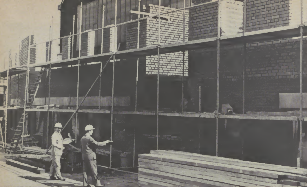
Das Bürogebäude an der Seite der Rohrwerk-Kaltbeton wurde aufgestockt. Hier soll Zentrale Betriebswirtschaft untergebracht werden.
