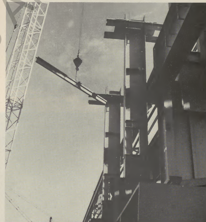
Der Turm der Senkrech vergüteanlage wird 40 m hoch.
