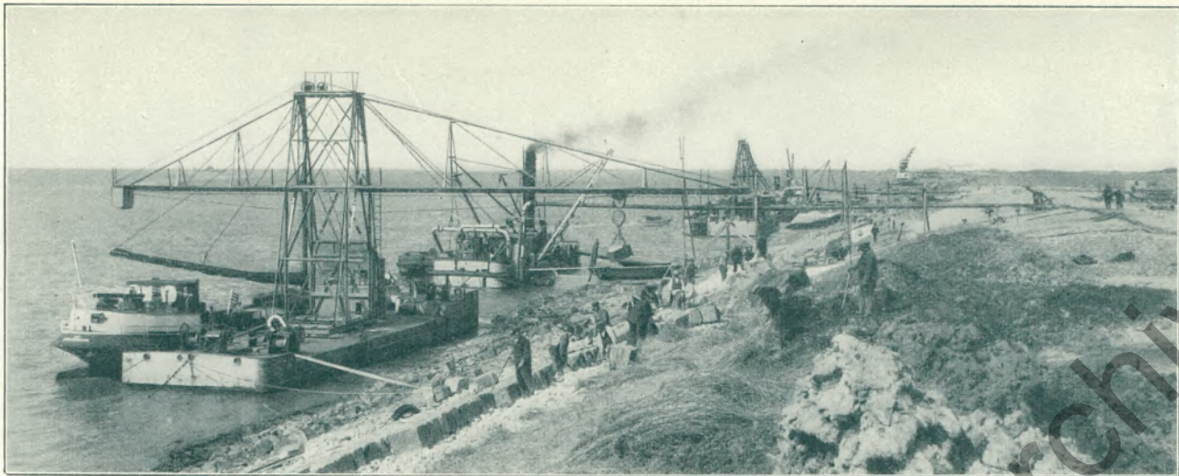
Bagger- und Pumpenanlagen am Wieringer Deich.
