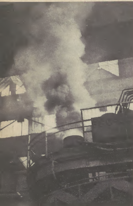
Wenn die Entstaubungsanlage ausfällt . .
