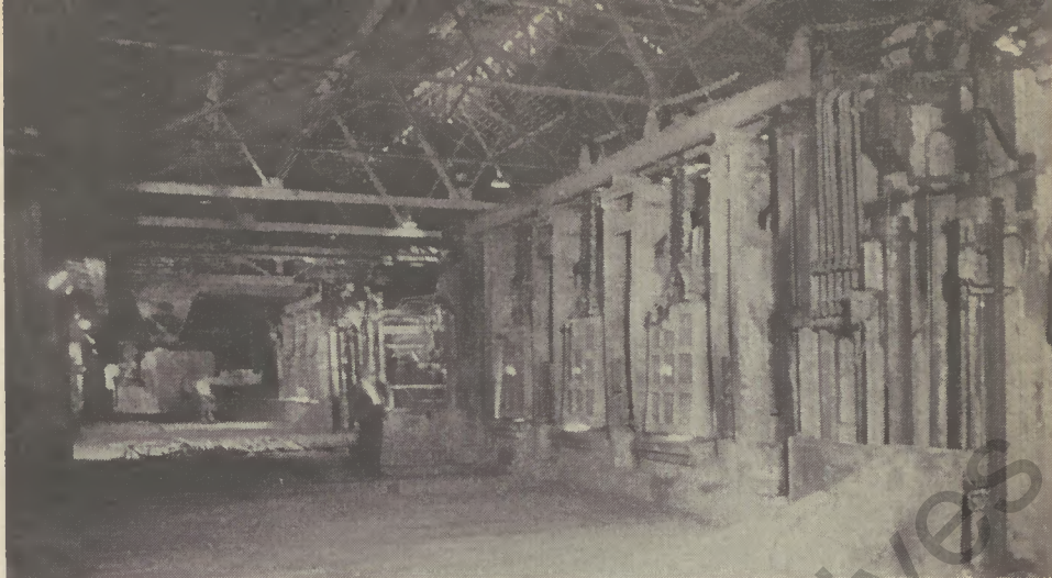
Die SM-Öfen in Oberbilk waren starr, der Abstich der Schmelze oft mit schwerer Arbeit verbunden.
