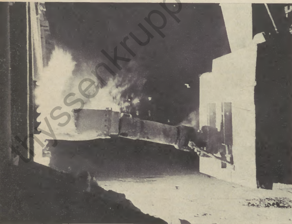
Die SM-Öfen in Oberbilk wurden mit Mulden beschickt.
