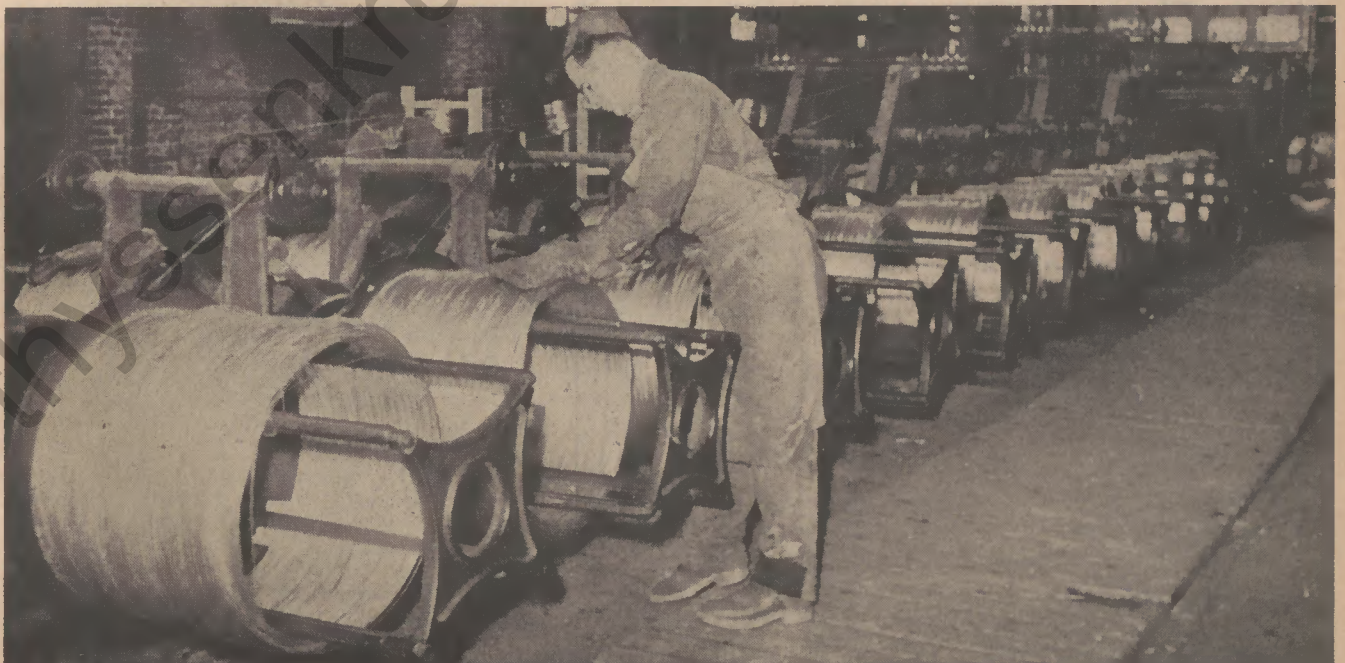
Auflaufseite der Drahtverzinkung
