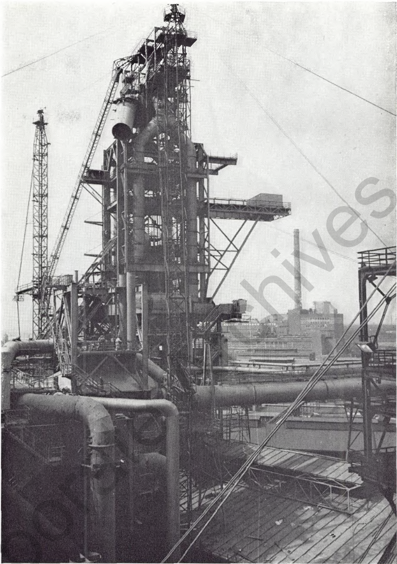
DAS BILD zeigt den neuen Hochofen 6 in Ruhrort mit einem Gestell-Durchmesser von elf Meter in Bau
