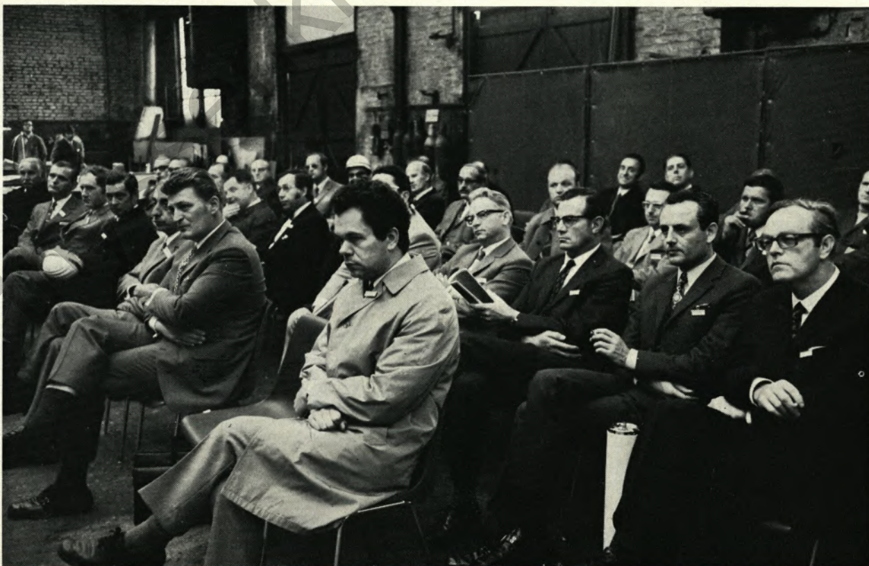
46 Tunnelbaufachleute wohnten den Versuchen bei, die zum Nachweis der Traglast von Hoesch-Tiefbau-S-Profilen durchgeführt wurden.
