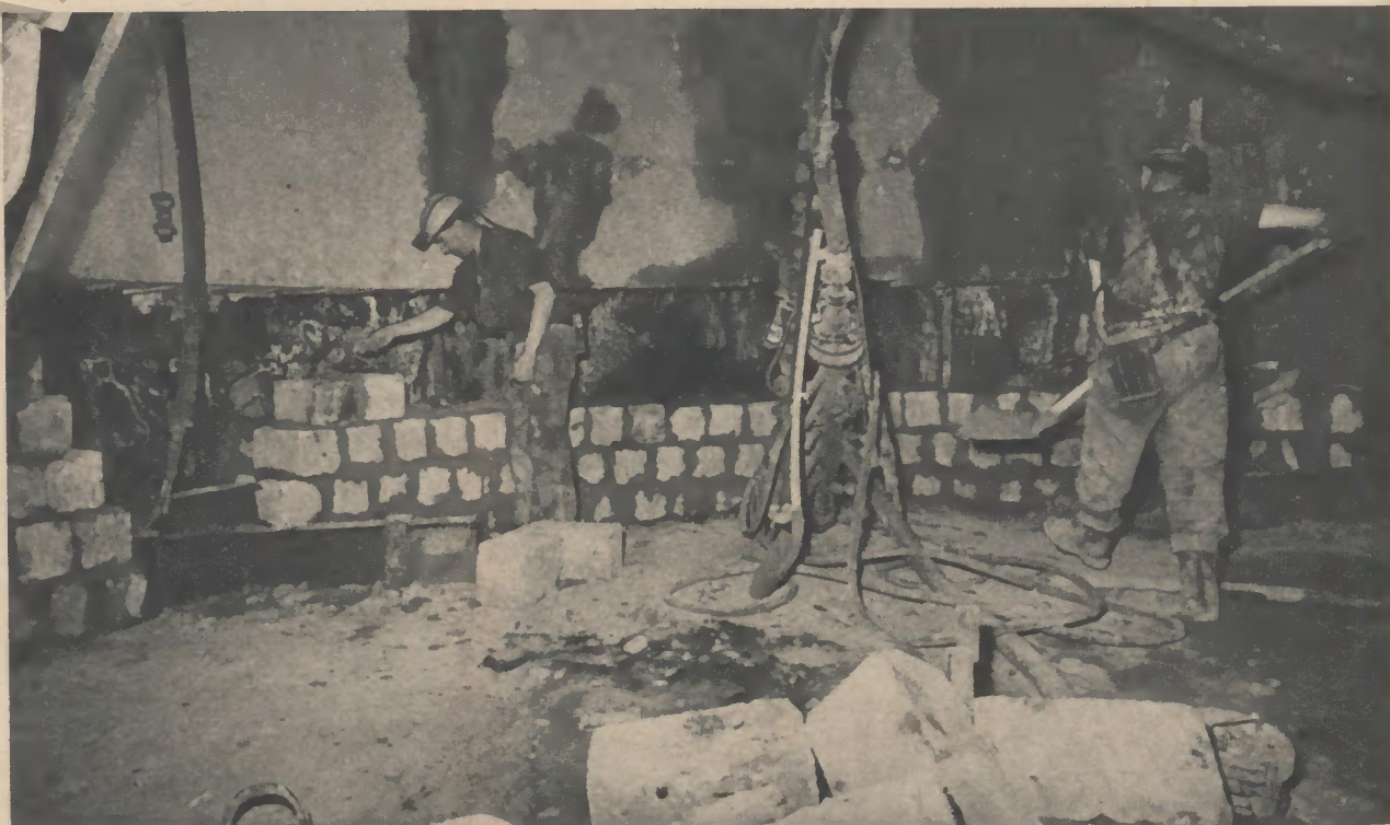
► Mit den fortschreitenden Arbeiten beim Ausmauern der Schachtwand hebt sich die Schwebebühne, auf der hier Maurer Knäpper (links) eben dabei ist zu verfugen und Drittführer Grahlmann den Anschluß an das Gebirge verfüllt
