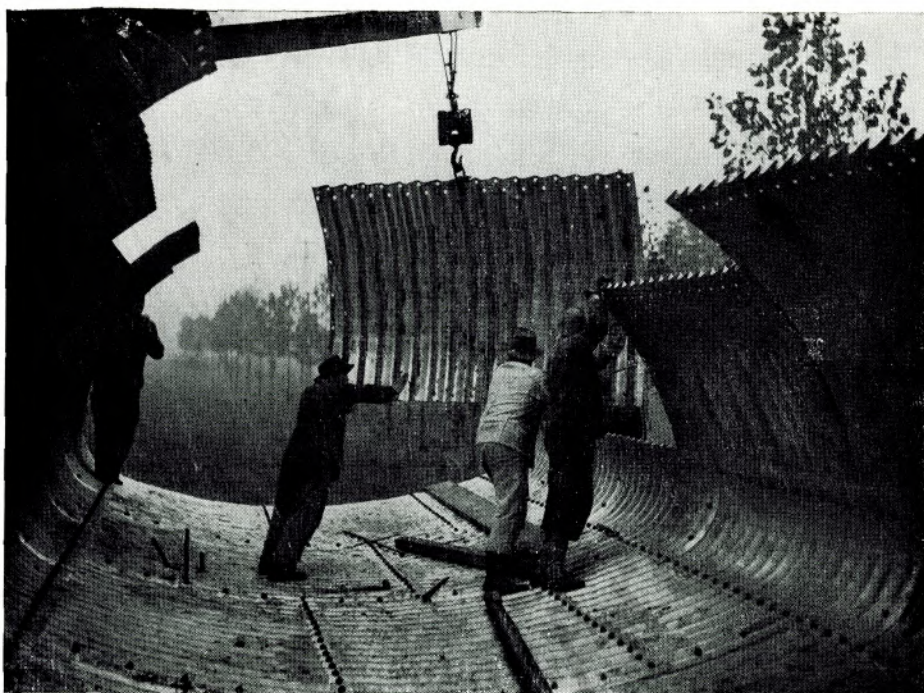
Dieser Durchlaß für die Seseke unter einer Straße bei Unna hat eine Höhe von 2,60 Meter und eine Spannweite von 4,25 Meter. Er ist eines der verschiedenen Erzeugnisse, die von der Armco-Thyssen Breitband-Verarbeitung in Dinslaken seit einigen Monaten für den deutschen und ausländischen Markt erzeugt werden. Unser Bild zeigt die Montage der fertigen Bau-Elemente
