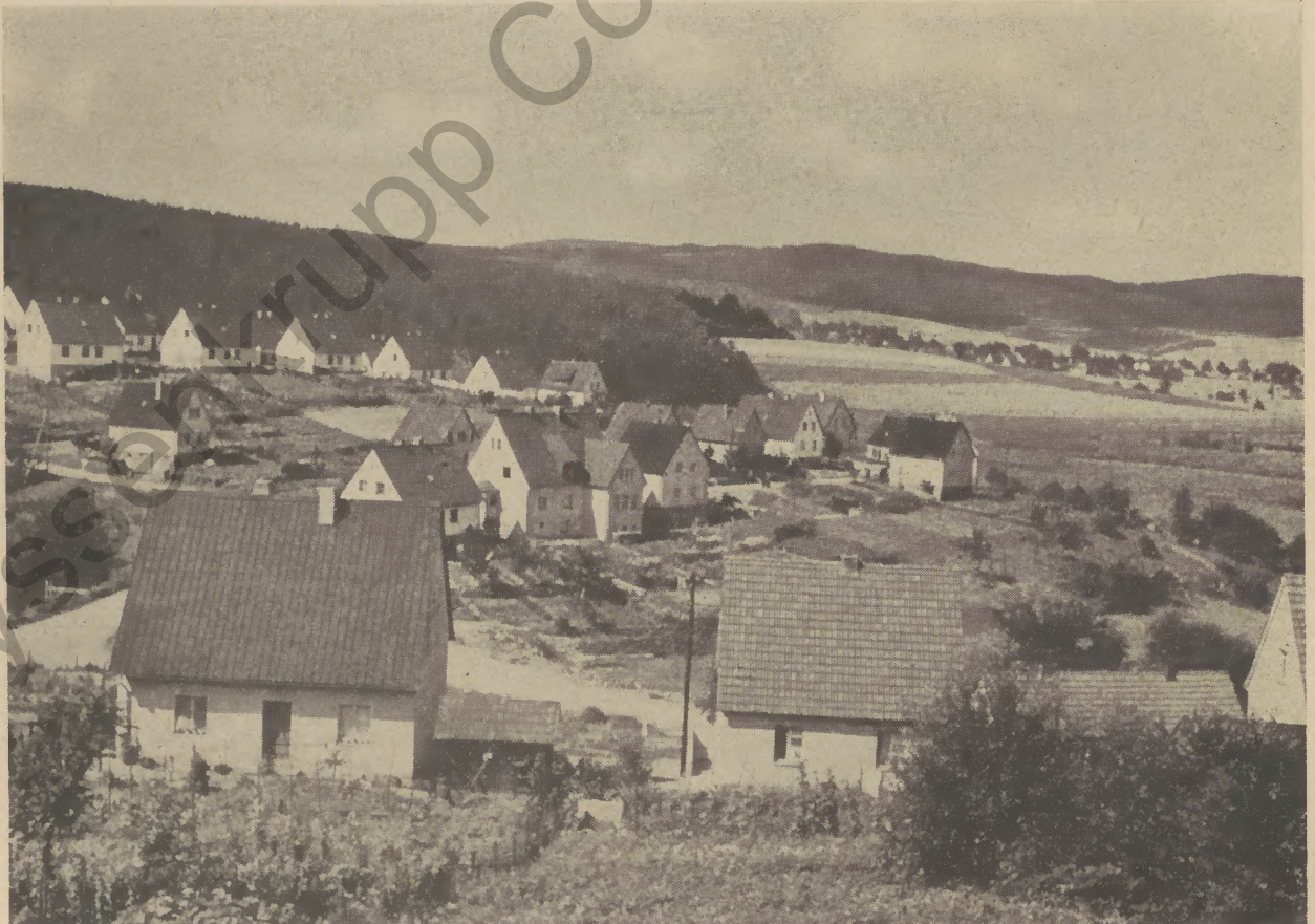
Zwei Häuser in der Bockelbach: links blechgedeckt, rechts mit Ziegelpfannen gedeckt
