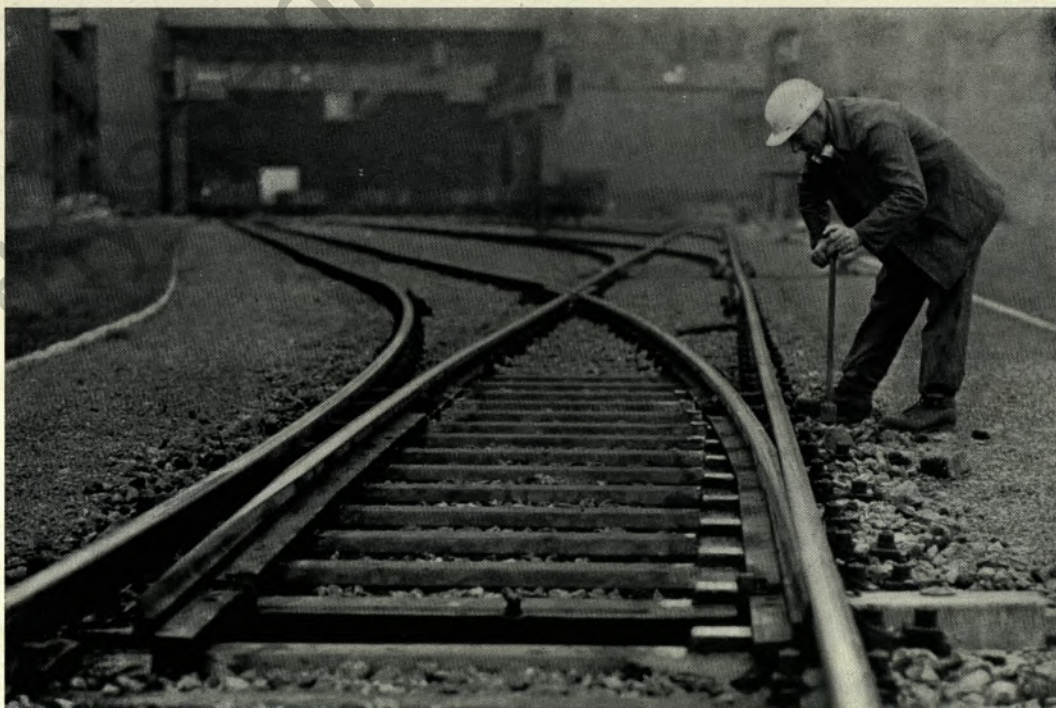
Die großen Gleisbau-Arbeiten sind geschafft, der Eisenbahnbetrieb rollt
