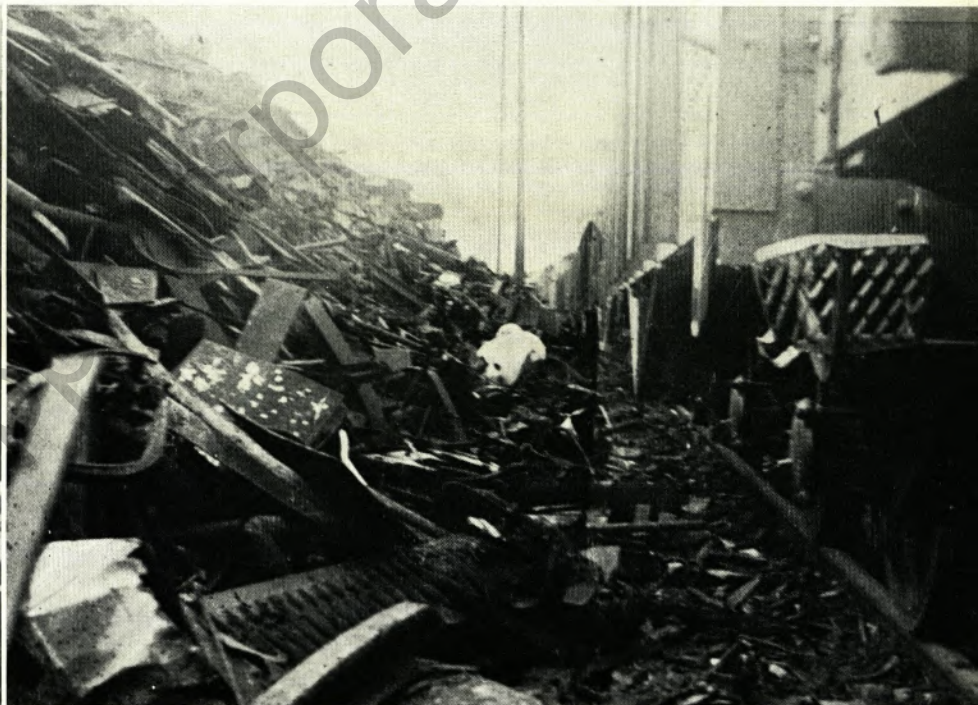
Nicht „profilfreie“ Gleise rufen immer wieder Zerstörungen hervor, wie verbogene Fußtritte, abgerissene Seitenwandungen und abgeschlagene Seillösen.
