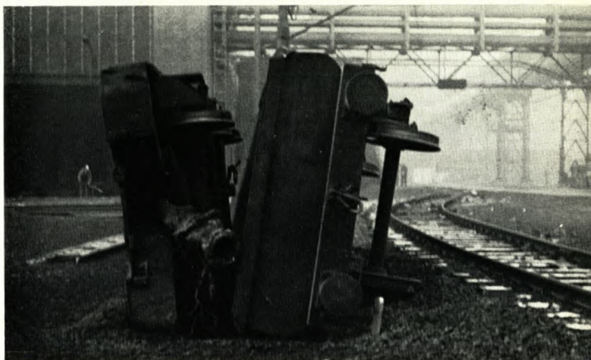
Einseitige Beladungen führen stets zu Entgleisungen mit entsprechenden Wagenbeschädigungen.
