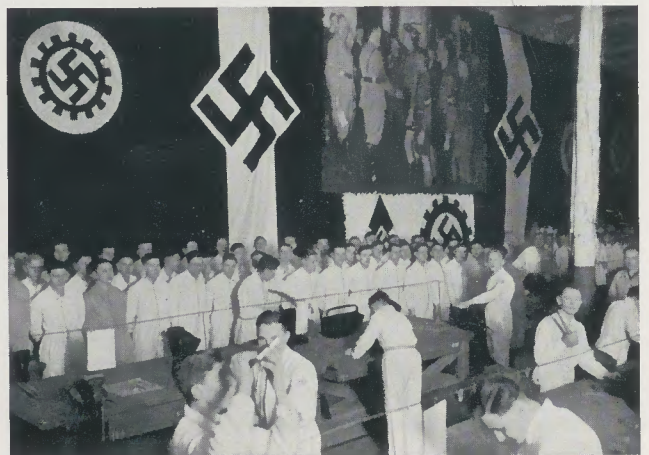
Die Lehrwerkstatt bei den praktischen Arbeiten
