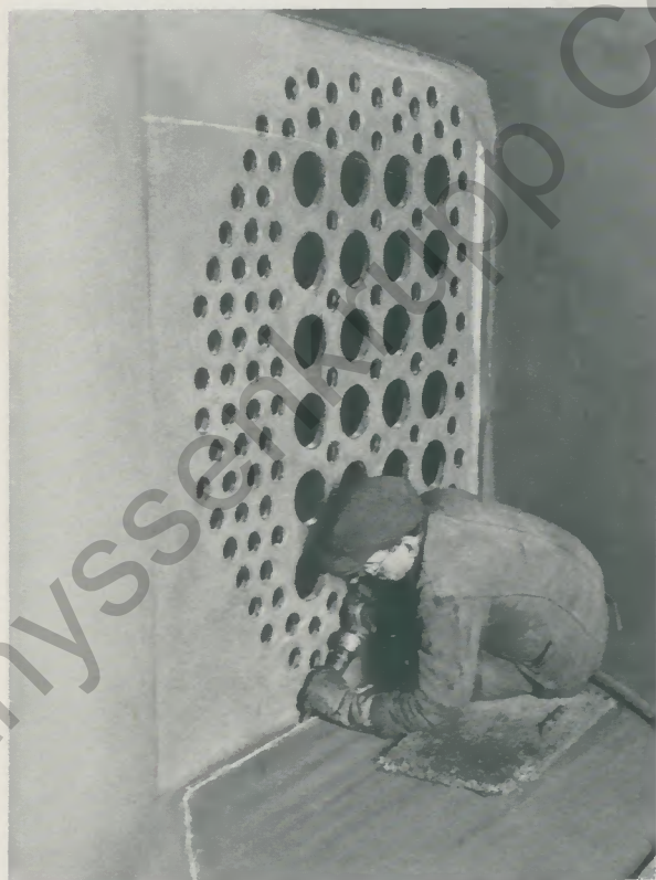
8 Ausarbeiten der Schweißfuge für die Kappnaht
