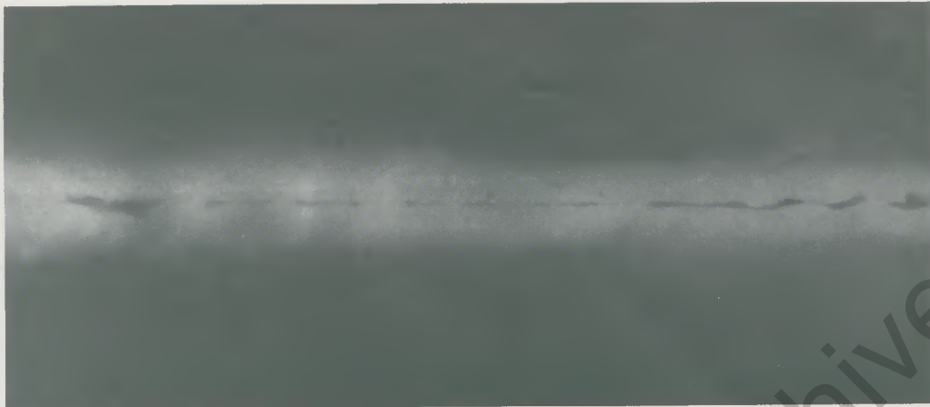
23 Die Schweißung ist mit einem feinen durchlaufenden Nahtwurzel-Bindefehler und einigen kleinen Schlackenresten behaftet. Werkstoff-Dicke 14 mm.
