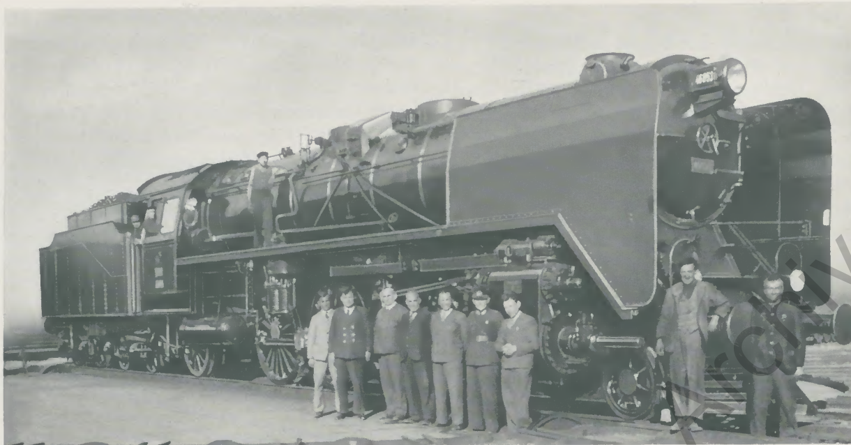
Während der Abnahme
