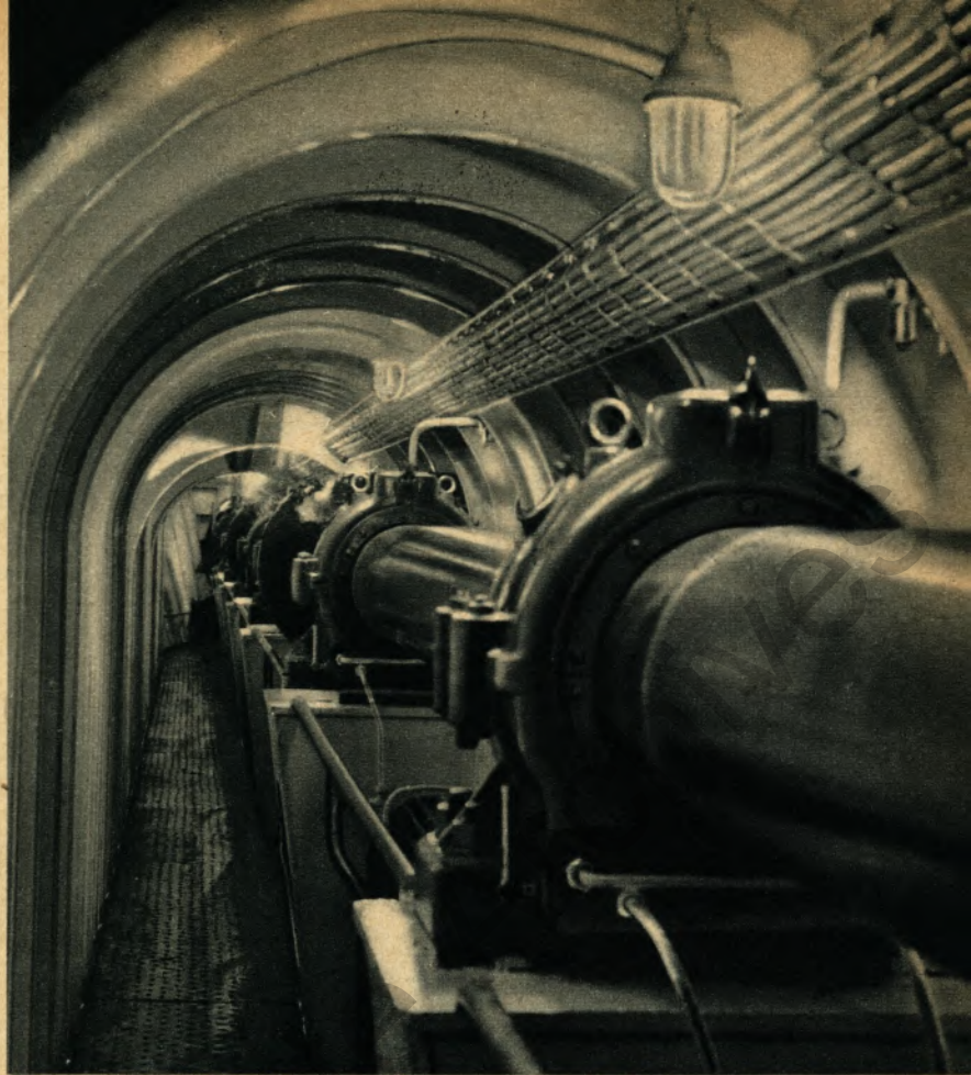
Blick in den Wellengang der „Costa Rica“. Auch diese Welle wurde im Hammerwerk und in den mechanischen Werkstätten der Westfalenhütte einbaufertig hergestellt
