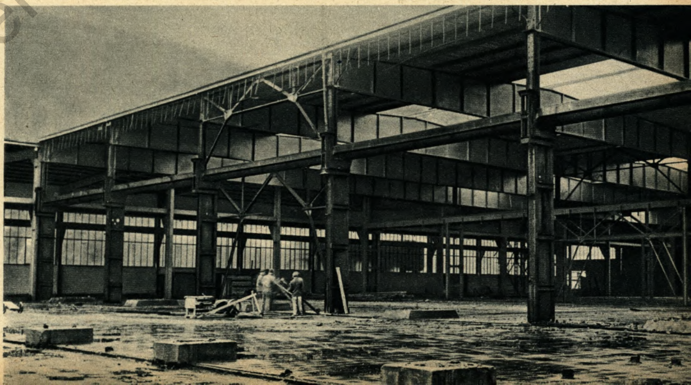
Ehemalige, im Krieg zerstörte Werkshallen der Schmiedag AG in Hagen werden zur Zeit wieder aufgebaut, um die neuen Rohrschweißanlagen der Hiltruper Röhrenwerk GmbH aufzunehmen. Mit den hier gefertigten Rohren bis zu 200 mm Durchmesser will das Hiltruper Werk sein Produktionsprogramm abrunden.
