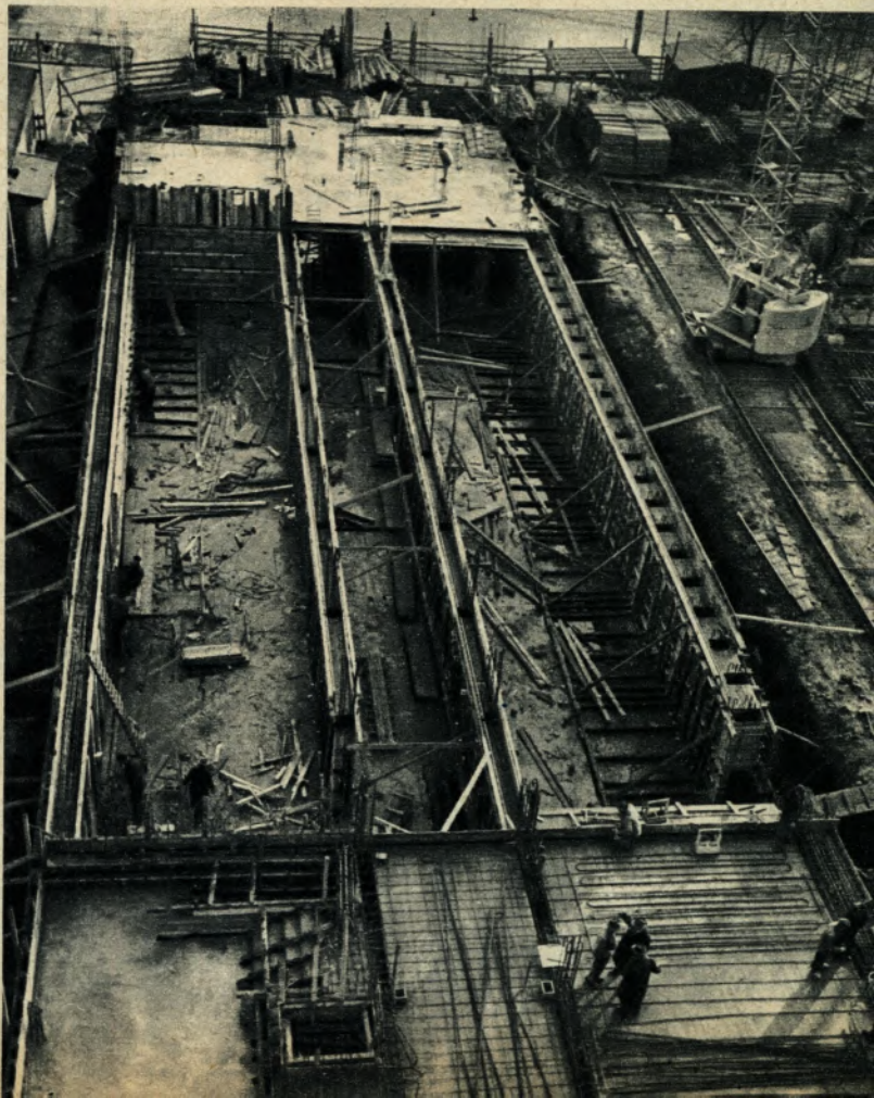
Die Fundamente zum Erweiterungsbau des Hoesch-Verwaltungsgebäudes an der Eberhard- straße in Dortmund sind gelegt
