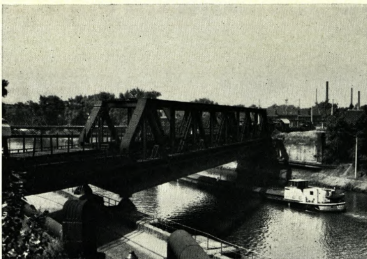
Die vorhandene Brücke vor Beginn der Bauarbeiten, daneben sind die noch unbeschädigten Widerlager der im Krieg zerstörten zweiten Brücke zu erkennen.
