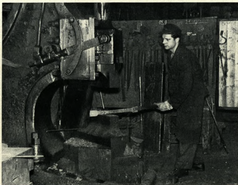
Schmied Helmut Jaschek beim Ausschmieden eines Stahlteils mit dem Schmiedehammer.
