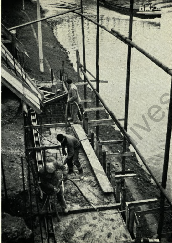
Der Beton, den Spezialfahrzeuge heranfahren, wird hier durch Rüttler an der westlichen Auflagerbank verdichtet.
