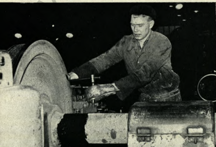
Dreher Dieter Bode beim Drehen eines Radsatzes.
