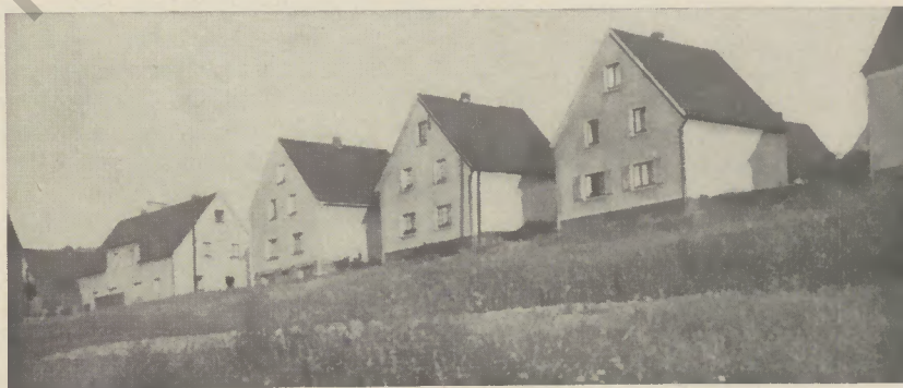
Einige der ersten Häuser des Gemeinschaftswerkes Wohnungsbau Herdorf e.V. in ihrem heutigen Zustand auf dem sogenannten Krankenhausplatz
