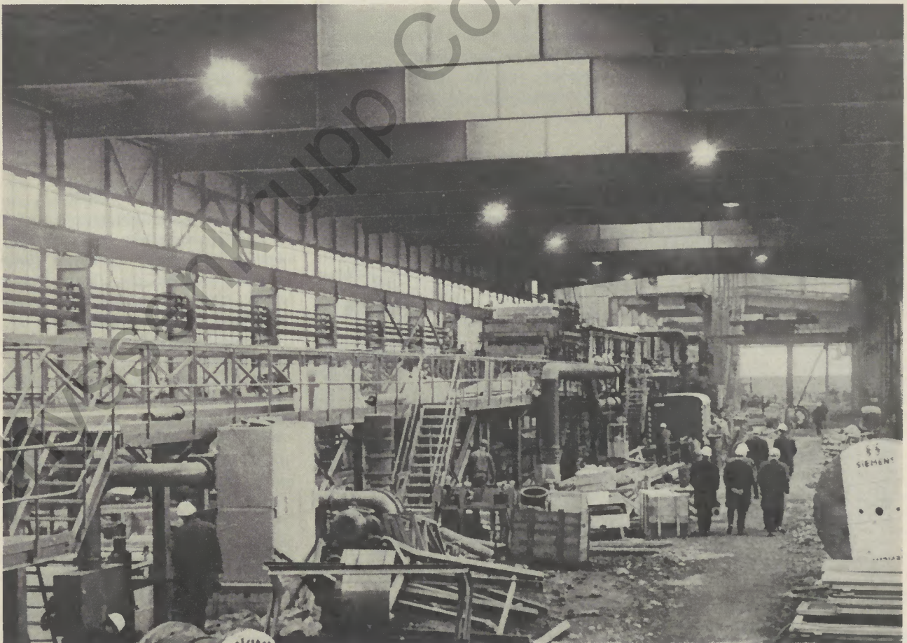
Die Halle für die Bandverzinkungsanlage in Eichen
