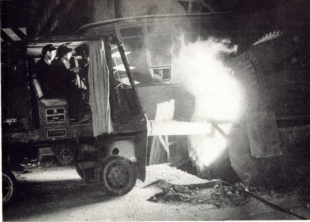
Beim Füllen eines Konverters mit dem Chargierwagen
