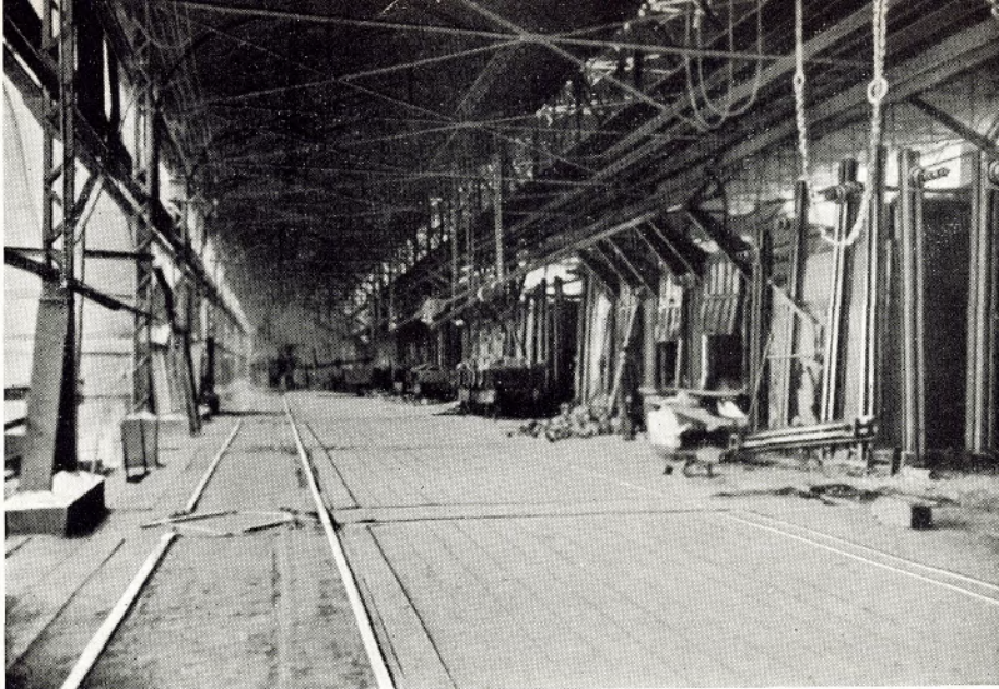
Die Ofenbühne des früheren Martin-Stahlwerkes I der ATH mit Chargierkran
