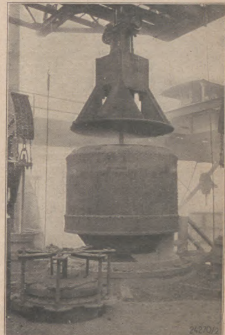
Abb. 6: Ansetzen des Kübels am Hochofen
