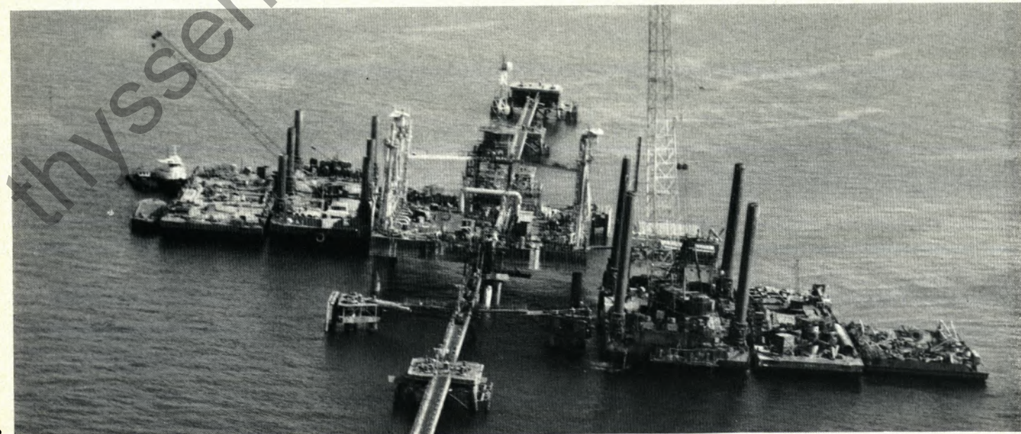
Der neue Löschkopf bei Mina Al Ahmadi, für den Thyssenrohr wesentliche Teile, so unter anderem die Anlegedalben, lieferte.
