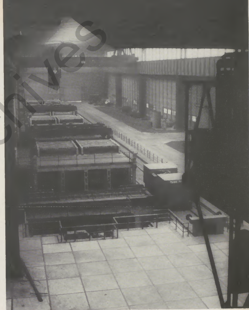
... die Tiefofenanlage besteht aus sechs kleinen und sechs großen Kammern. Sie nimmt den vom Stahlwerk angelieferten, noch heißen Rohstahl auf ...
