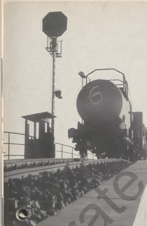
...um eine rationelle Bearbeitung des rollenden Materials zu erreichen, wurde eine zentrale Anlage von erheblicher Ausdehnung notwendig. Vor allem mußte ein Ablaufberg geschaffen werden...
