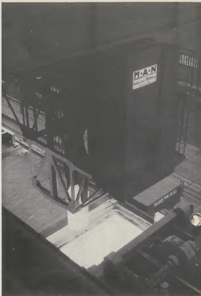
...Belegung und Entleerung der Öfen erfolgen durch zwei Tiefofen-Zangenkräne. Die den Öfen entnommenen Blöcke werden auf den ferngesteuerten Blockkipperwagen gestellt, der sie zum Zufuhrrollgang bringt und auf diesen ablegt...
