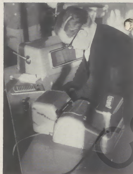
...während der Zug langsam über die Waage rollt, braucht unser Mitarbeiter Netz nur jeweils die vorbereitete Karte in die Wiegeanlage einzulegen. Das Gewicht der einzelnen Waggon wird automatisch auf die Wiegekarte aufgedruckt...
