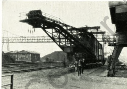
Auch das Oberteil ist ohne Störung um die Ecke an der Probenahme zum Westufer eingebogen und rollt, dem Portal nachfolgend, zum neuen Einsatzort.
