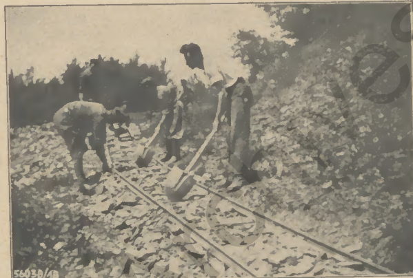
Schienen werden verlegt
