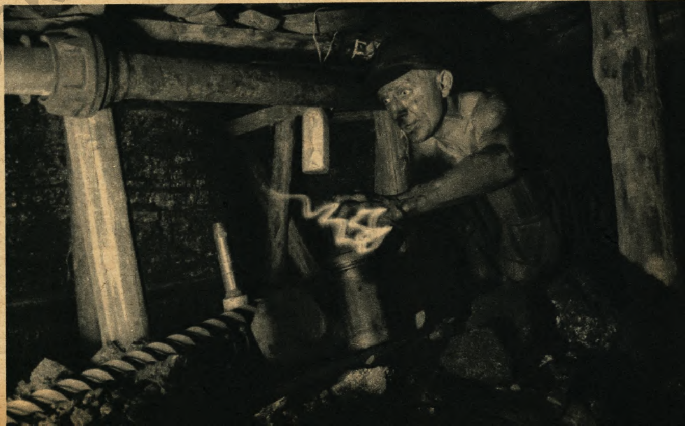
Nach dem Schrämen wird ein Sprengloch gebohrt, um durch Schießen die anstehende Kohle zu lösen.
