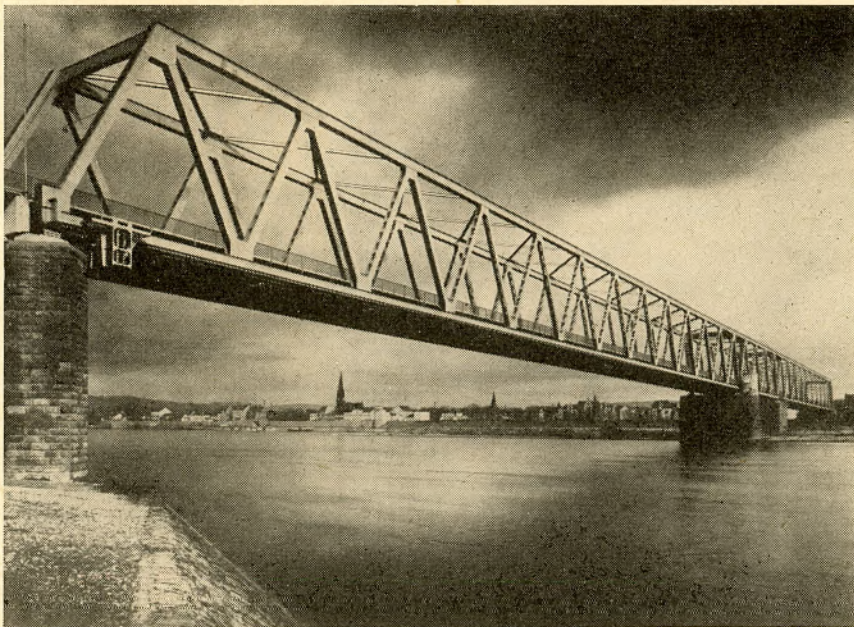
Die Straßenbrücke, die den Rhein bei Neuwied-Weißenthurm überspannt, stellt eine typische, neuzeitliche Fachwerkbalkenbrücke dar. Trotz der nüchternen Sachlichkeit der Konstruktion bietet die Brücke dem Beschauer ein harmonisches Bild
