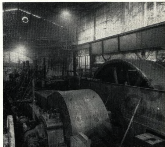
Gesamtansicht der ausgedienten Maschine, die seit über 50 Jahren ihren Dienst versah. Rechts im Bild das Getriebe
