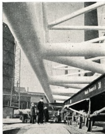
UNSER TITELBILD zeigt die Verladung eines Kranbahnträgers aus Stahlrohr im Werk Thyssen
