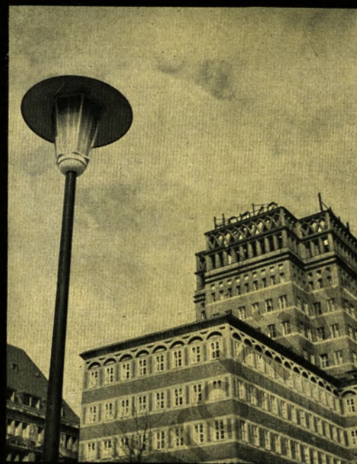
▲ Eine Pilzleuchte, konisch gezogen, mit ganz glattem Schaf, in unserem Werk Dinslaken hergestellt
