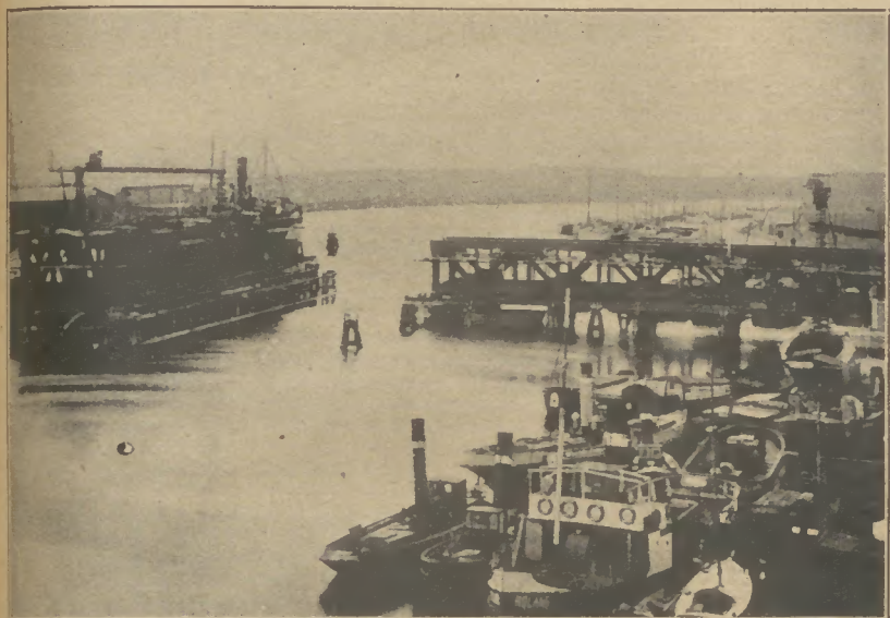
Montage der Drehbrücke, erste Probedrehung von Hand.
