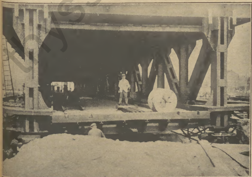
Ansicht des Endabschlusses der unteren Fahrbahn der Drehbrücke.
