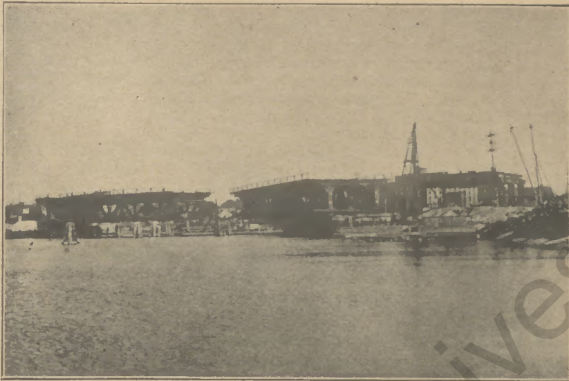
Ansicht der Gesamtmontage.
