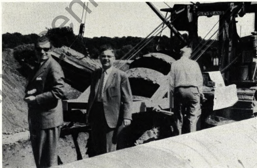
Prok. Thoenke und Ing. Rudat (von links) an der Baustelle im Elsaß. Im Hintergrund arbeitet die Grabenfräse. Die endlos verschweißten Rohre liegen zum Absenken bereit
