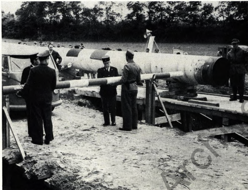
Am 4. Juli überquerte die 760 km lange südeuropäische Pipeline die deutsch-französische Grenze bei Lauterburg. Damit ging der Bau der Ölleitung planmäßig dem Ende entgegen
