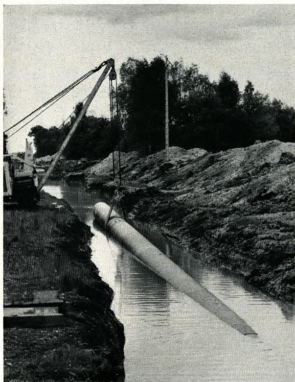
Wie schwierig die Arbeiten waren, zeigt das obere Bild. In dieser Moorstrecke standen die Gräben voll Wasser. — Foto Mitte: Das Absenken des Rohrstranges. — Unten: Seitenbaumtraktoren durchqueren einen etwa 1 Meter tiefen Bach im Elsaß
