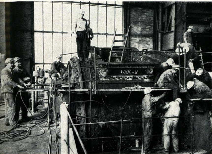
Der Roheisenmischer im Mülheimer SM-Werk III wurde kürzlich nach 6jähriger Betriebszeit gründlich überholt. Die Reparatur erstreckte sich auf die Erneuerung der feuerfesten Ausmauerung, die Instandsetzung der Einfüllöffnung und die Ausbesserung von Blechschäden
