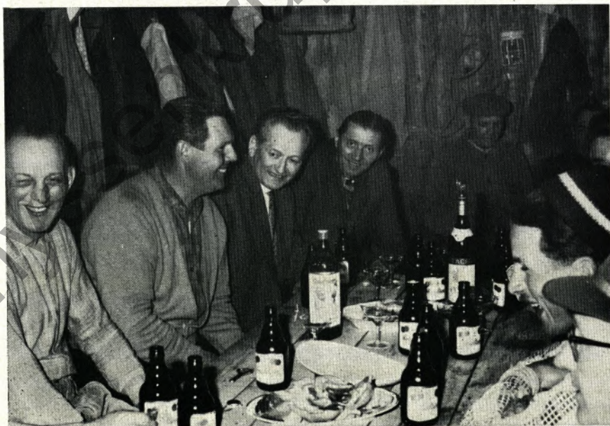
Gemeinsam mit den Bauarbeitern feierten die zukünftigen Hausbesitzer, unsere Belegschaftsmitglieder Borauke und Schmitz (3. und 4. von links), Anfang Mai das Richtfest
