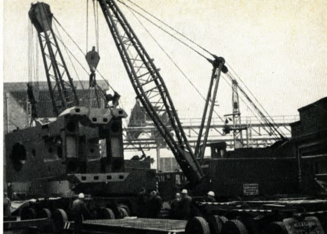
Mit Hilfe von Autokranen wurde in Immigrath eine neue Maxima-Press abgeladen, die für die Herstellung von Flanschen eingesetzt wird
