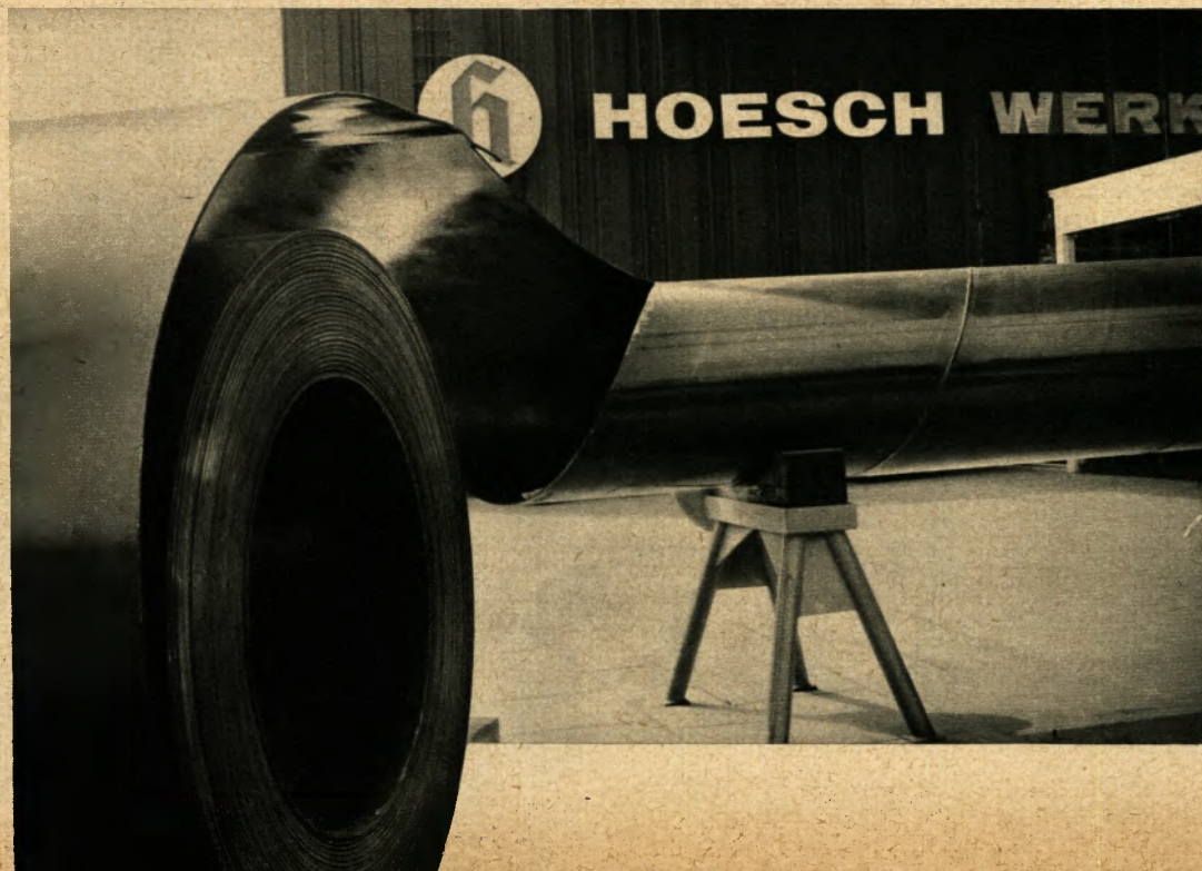
► Im Werk Barop werden spiralgeschweißte Rohre nach einem neuen Verfahren hergestellt. Unser Bild ist während der Industriemesse in Hannover aufgenommen worden.
