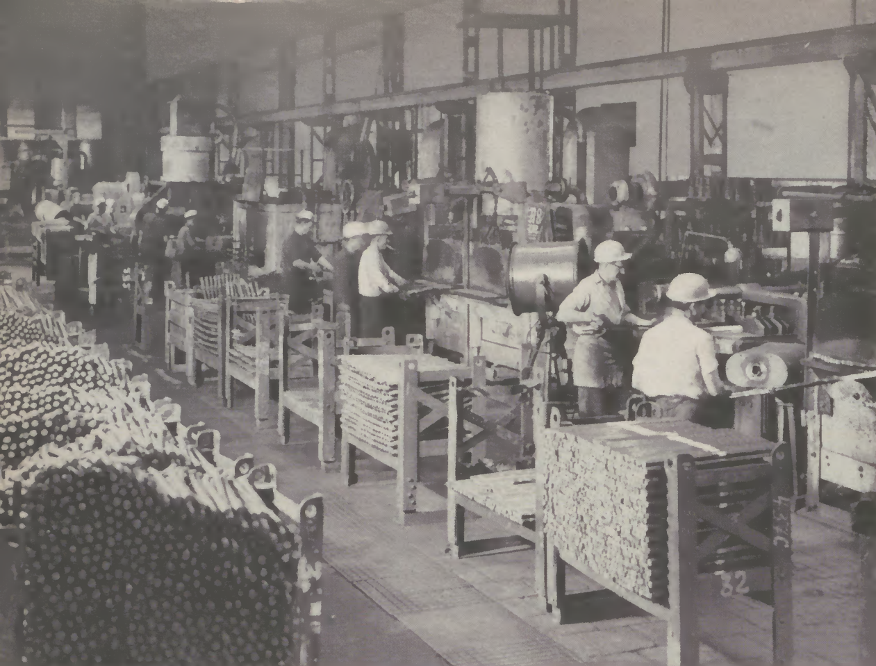
Gesamtansicht der Gelenkwellenstraße
