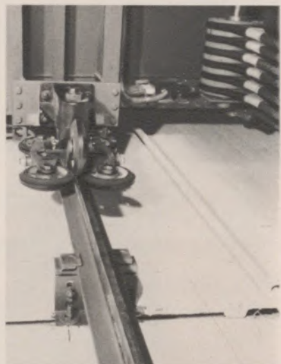
▲ Mit Rollen wird die Kabine an den Aufzugschienen geführt, deren Geradheit und Genauigkeit die Lauf- ruhe des Fahrstuhls bestimmt
