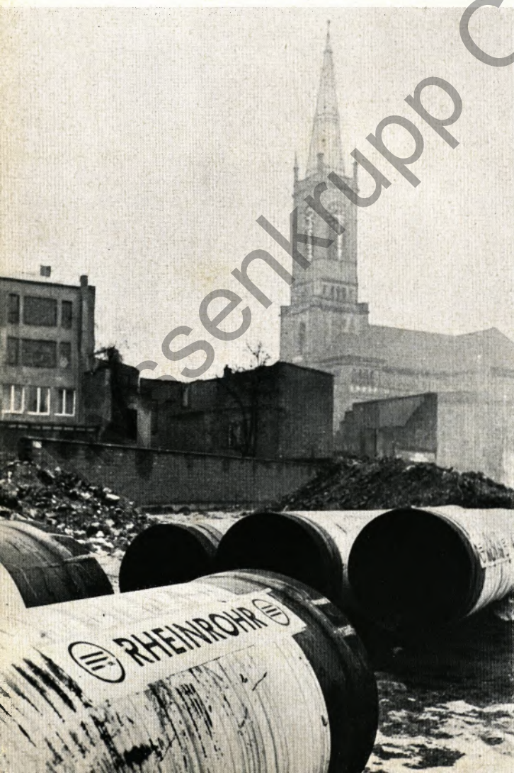
Rund 6 km Großrohre der Rheinische Röhrenwerke AG. werden z. Z. in Düsseldorf beim Bau der neuen Parallelstraße zur Kö sowie im Norden der Stadt verlegt
