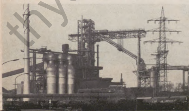
Hochofenanlage der August Thyssen-Hütte in Schwelgern, Tagesleistung 9000 t Roheisen
