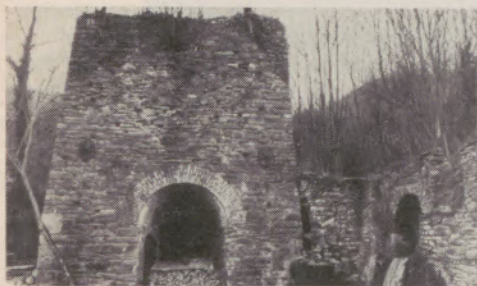
Unterer Teil des 1806 erbauten Hochofens in Zweifallhammer, Tagesleistung 1 t Roheisen
