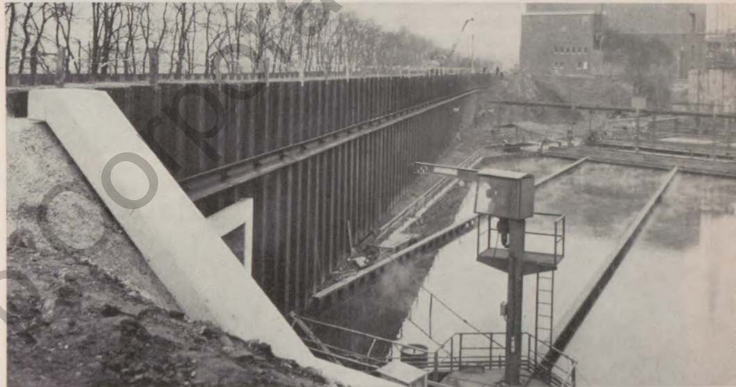
Spundwanddamm entlang des Klärbeckens im Werk Witten
