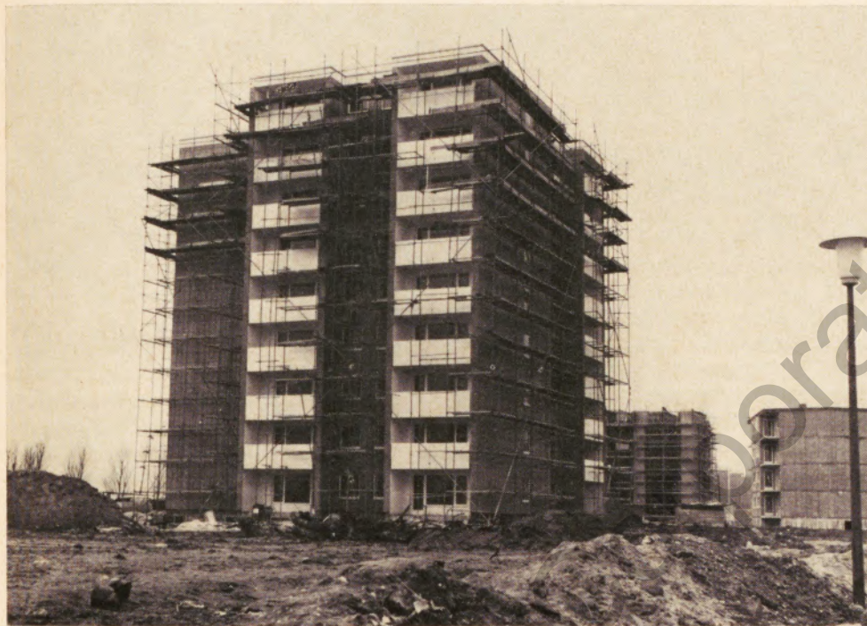
9-geschossiges Hochhaus mit 45 Wohnungen an der Dülkener Straße in Krefeld.
