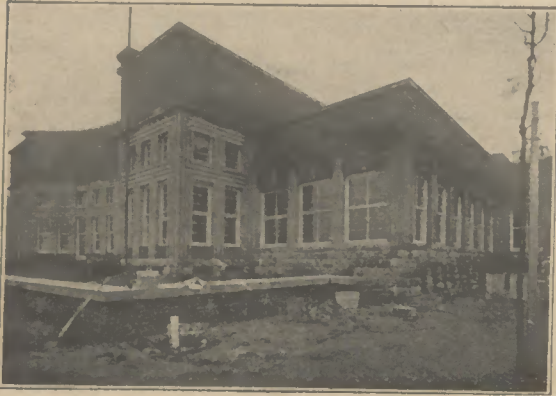
Das Rheinterrassenrestaurant vor der Fertigstellung.
