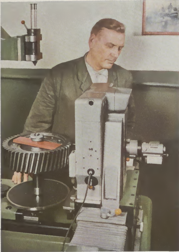
Abb. 3 Vermessen eines Zahnrades auf Zahnform (Evolvente) und Zahnrichtung
