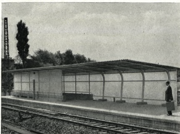
Die neugeschaffene Überdachung auf dem Bahnsteig Düsseldorf-Unterrath wurde von unserer Mülheimer Neubauabteilung konstruiert und von der Abteilung Stahlbau (Thyssen) montiert
