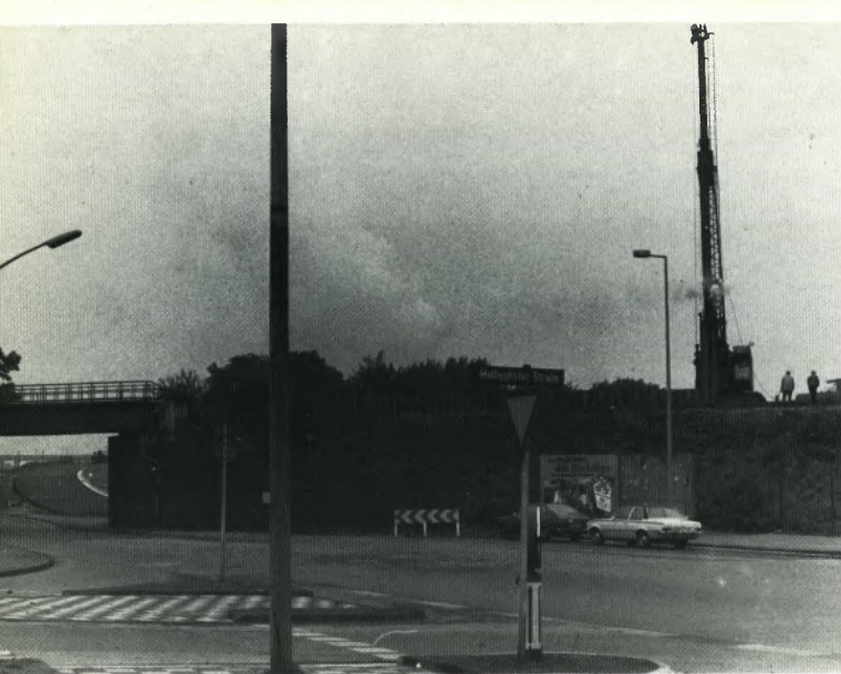
Rammung der Baugrubenumschließung für die Brückenerweiterung Essener Straße. Unter der alten Brücke ist die Rampe zur Klockesbrücke sichtbar.
