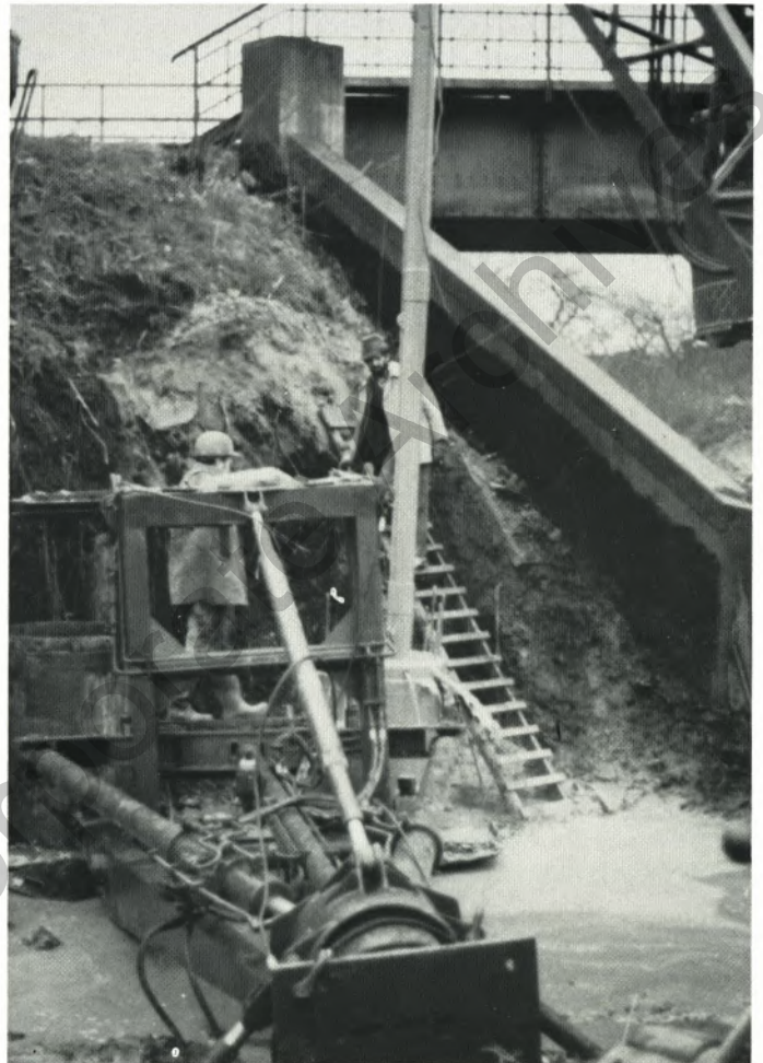
Verrohrungsmaschine für Großbohrpfähle. Das Betonieren eines Pfahles erfolgt mit Hilfe von Schüttrohren.
