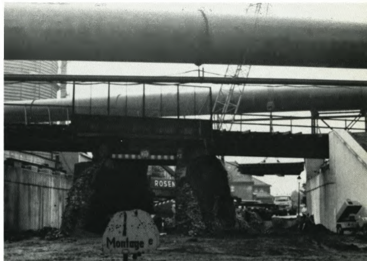
Montage des ersten Überbauteiles. Im Vordergrund der Rest der „Mausefalle“ mit Behelfsbrücken.
