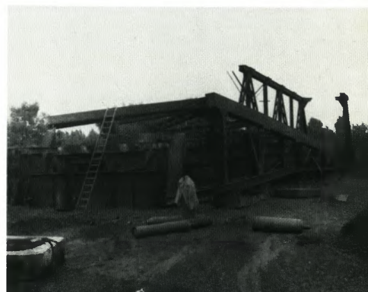
Die bereits teilweise verschrottete Brücke auf dem alten Werksbahndamm.
