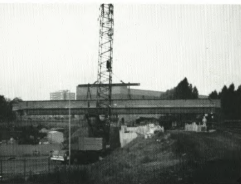
Transport des Brückentroges mit Spezial-Straßentieflader. Vorn links Autokran 160 t Tragkraft für die Montage.
