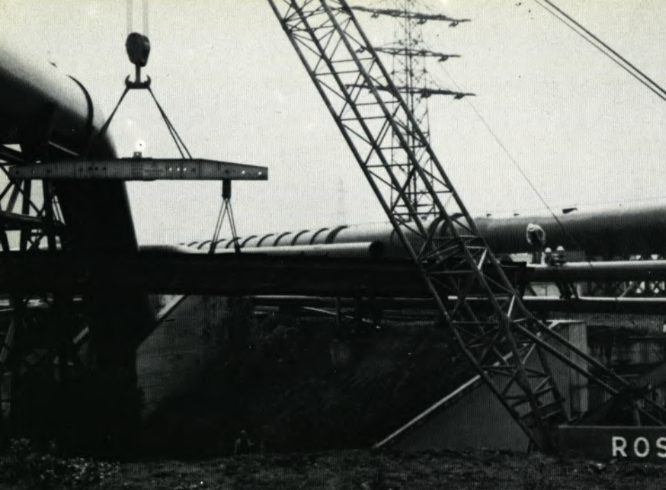
Einfahren des zweiten Überbauteiles zwischen den einzelnen Gasleitungen hindurch.
