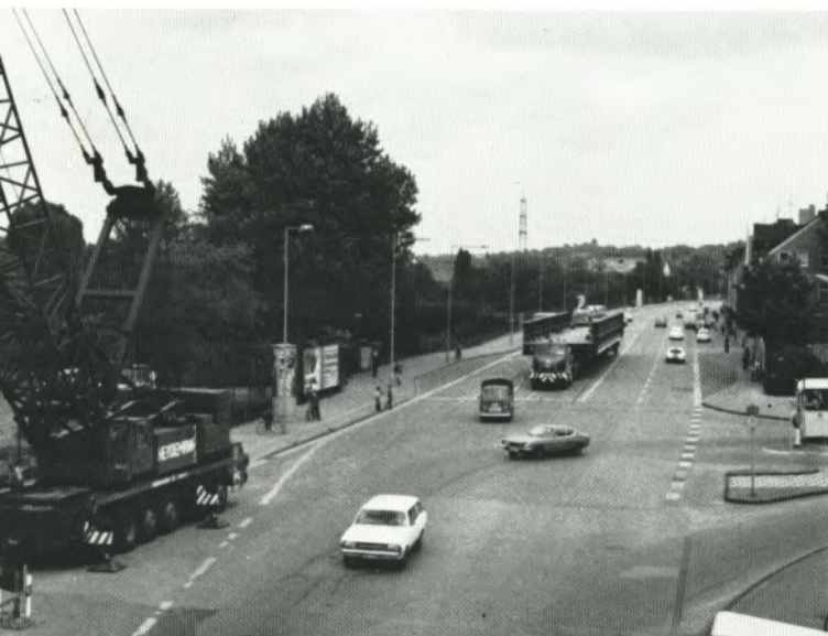
Transport des Brückentroges mit Spezial-Straßentieflader. Vorn links Autokran 160 t Tragkraft für die Montage.
