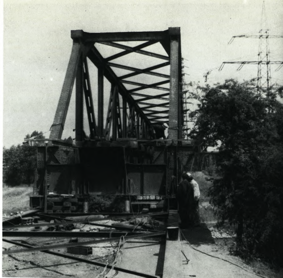
Die Brücke nach der Hebung. Die Schwellenstapel und Pressen sowie die Verschubbahn sind im Vordergrund zu erkennen.
