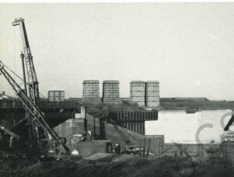
Nachdem das nördliche Widerlager fertiggestellt ist, werden die Großbohrpfähle für das südliche Widerlager hergestellt.
