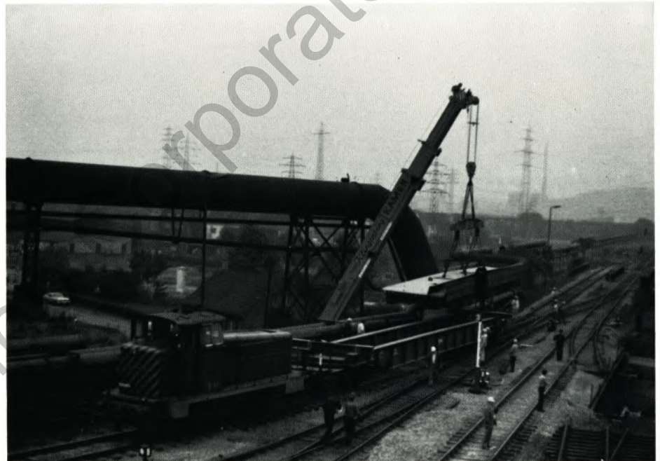
Umladen des dritten Überbauteiles vom Straßenfahrzeug auf den Eisenbahntiefadewagen. Rechts vorn die spätere Einbaustelle.
