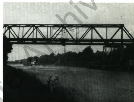
Die Brücke wird auf der „ENTERPRISE“ abgestützt.
