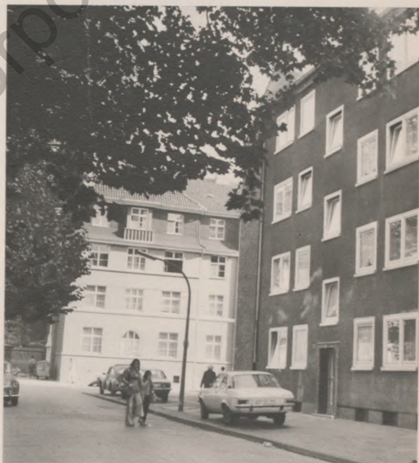
▲ Beide Häuser (an der Ecke Dreher- und Schlosserstraße) gehören zu den von Hoesch modernisierten Gebäuden
