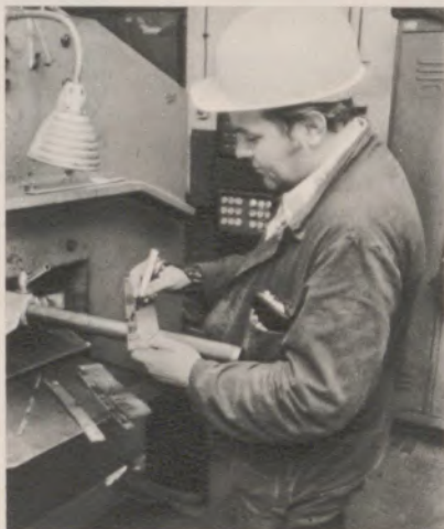
▲ Horst Austen beschriftet die an der Blechschere hergestellte handliche Probe
