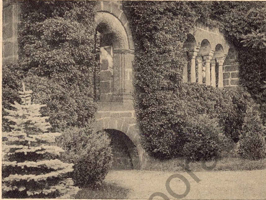
Selnhausen, Barbarossaburg — Arkaden und Portal
