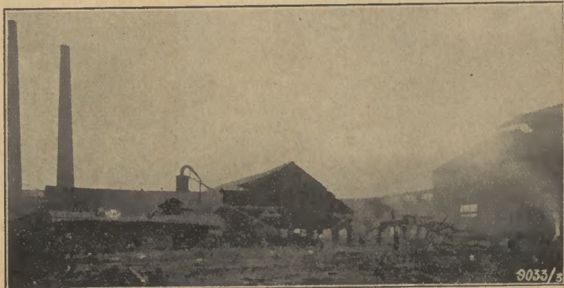
Abb. 5: Zustand der Baustelle nach Niederlegung des ersten Abschnittes
