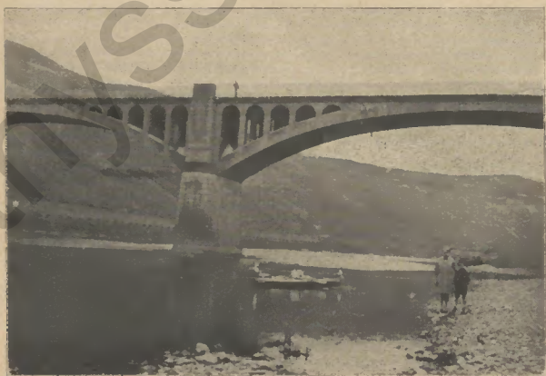
Abb. 3: Moselbrücke bei Trittenheim
