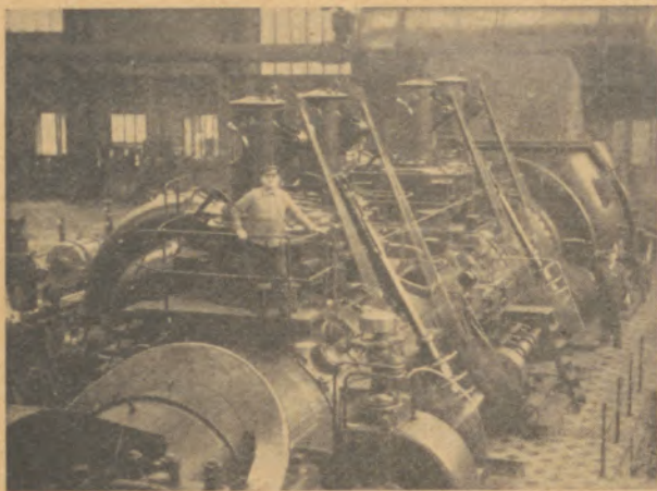
Hochofen-Gebläsemaschine C 6
