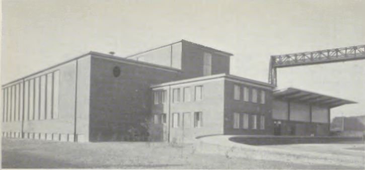
Außenansicht mit Mannschaftsraum
