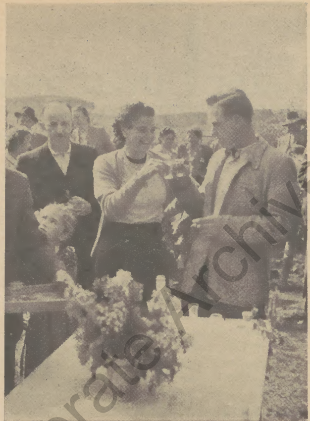
Frohe Gesichter bei den Siedlern und ein Prost auf den Baubeginn
